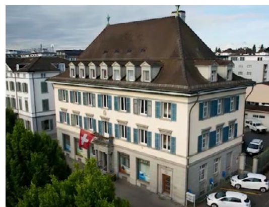
Das prachtvolle Gebäude an der Bahnhofstrasse 6 wird während eines Jahres saniert.
